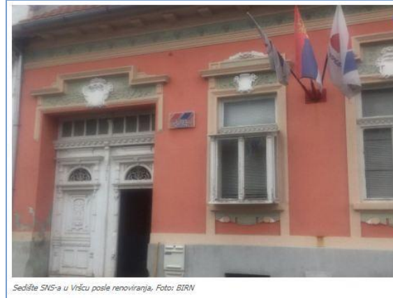
Sedište SNS-a u Vršcu posle renoviranja. Foto: BIRN
